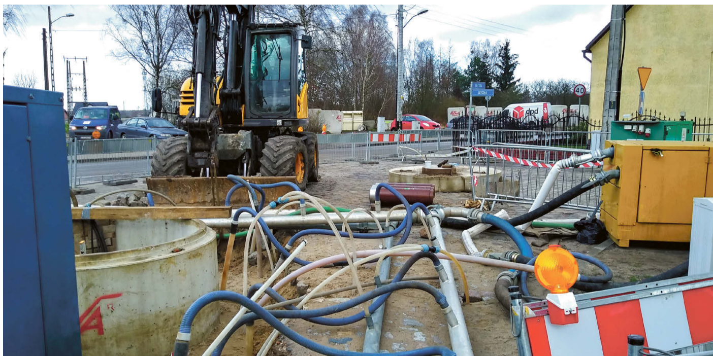
Prace przy ul. Bałtyckiej
