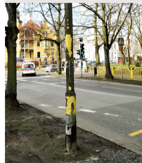
Ulica Felczaka - zaniedbane latarnie
