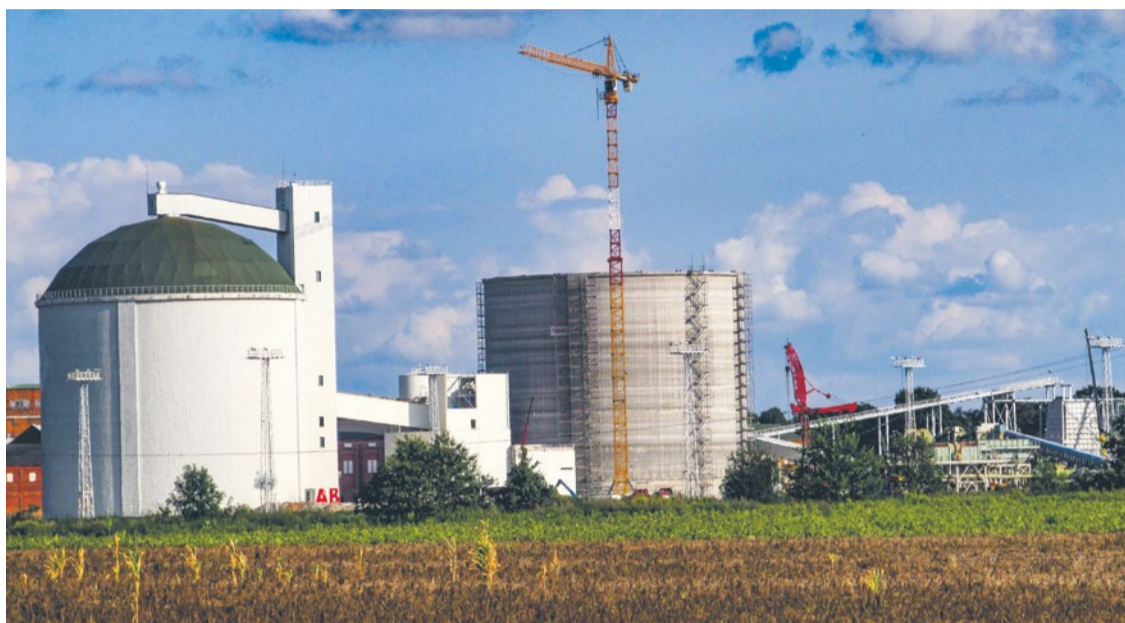
Pracownicy warszawskiej spółki „Strabag” budują przy cukrowni w Kluczewie jeszcze większy silos na cukier.
